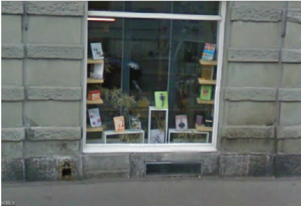
Links vorhandenes, recht zugemauertes Schuhputzloch mit Scheuereisen, Ankerstr. 12, 8004 Zürich
