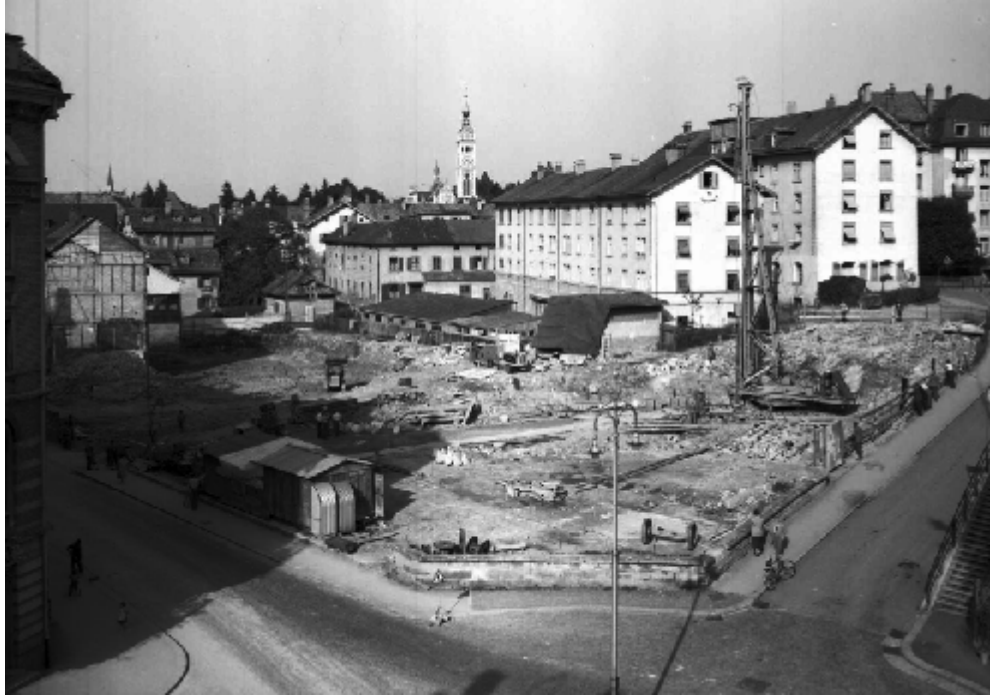
Dokumentiertes Verschwinden des Häuserbereichs zwischen Konkordiastrasse (rechts) und Lämmli brunnenstrasse (links), 1956
