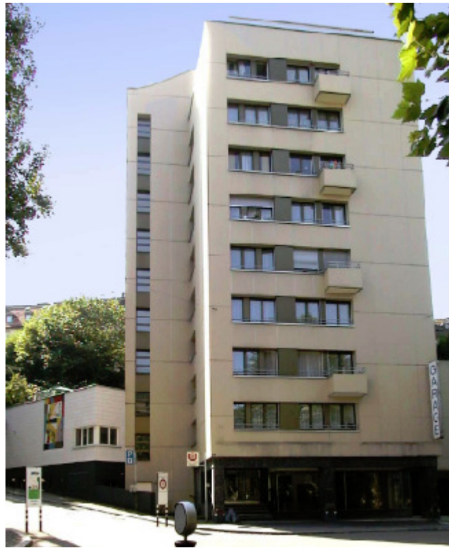
1956/57 erbautes Hochhaus Lämmli brunnenstr. 34 (links die Konkordiastraße)
